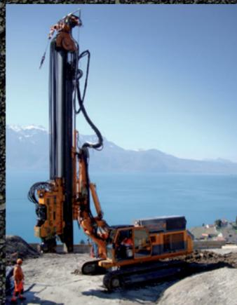
Teleskop-Rammgerät kurz vor dem Einbringen der Profile
